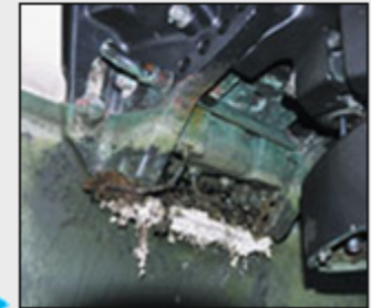
消耗したアノード
